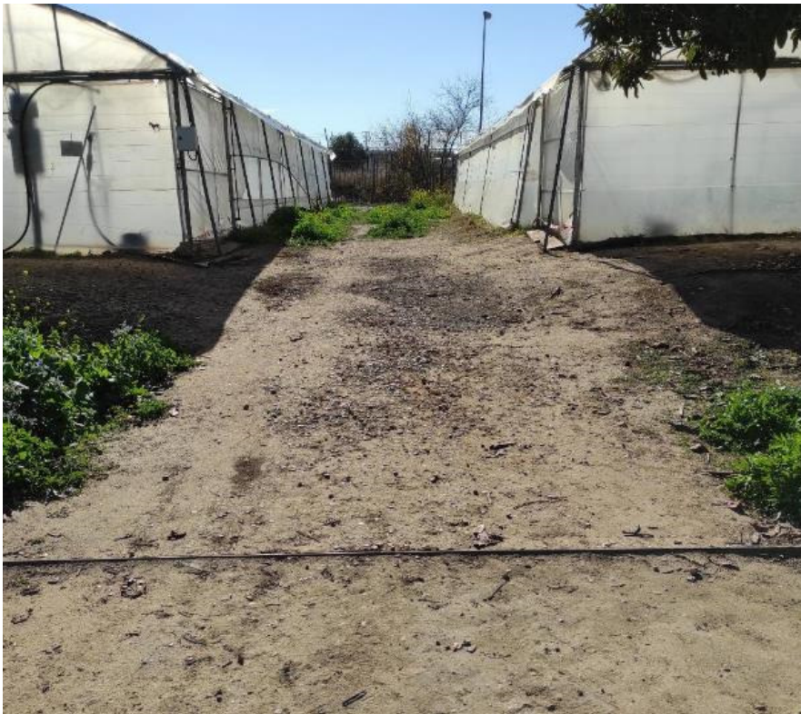
Hormigonado de entrada a invernaderos (en construcción)
