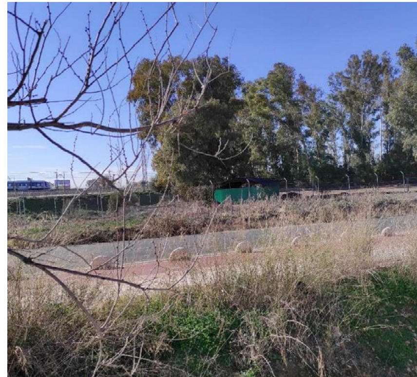
Acometida eléctrica y de agua a túnel de agricultura ecológica (en construcción)
